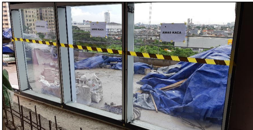
Gambar 4. Pembatas warning dipasang ke frame menggunakan selotip kertas.
