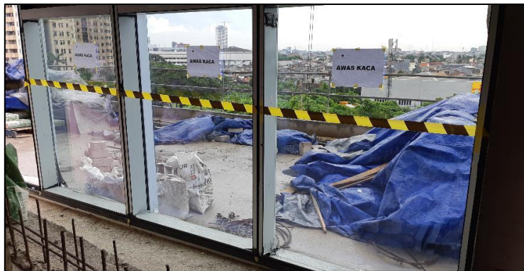
Gambar 4. Pembatas warning dipasang ke frame menggunakan police line .
